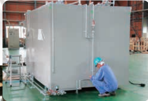
電気配線・配管
